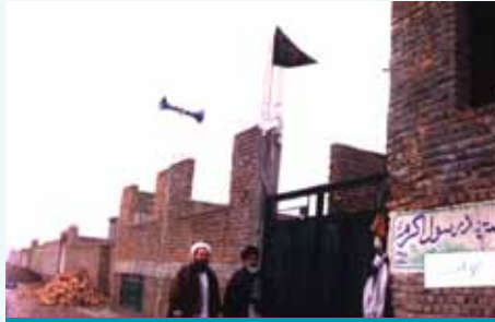
مسجد الرسول الأكرم عليه وآله قيد البناء
